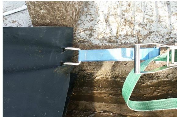
Фиксация резинового покрытия в задней части осуществляется с помощью планок ПВХ и анкеров: **одна планка каждые 27,5 см и 8 анкеров на планку.** (см. стр.3)
